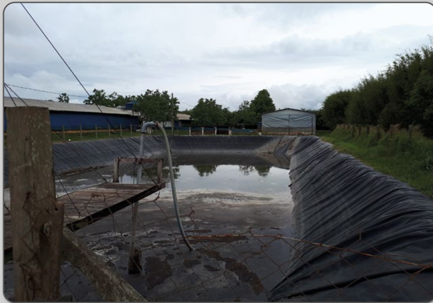
Figura 15 – Bacia de captação de dejetos líquidos de gado leiteiro confinado; após o tempo de compostagem, o material será destinado para fertilização do solo.
