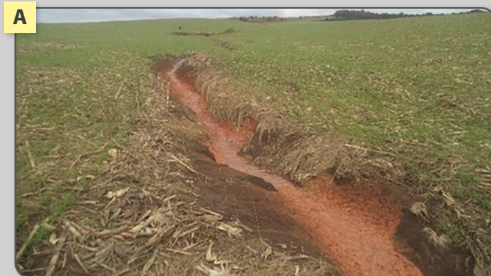
Figura 19 – Erosão em sulcos onde a água da chuva formou depressões do terreno e linhas de escoamento superficial (A) e evidências de escoamento de material argiloso (B).
