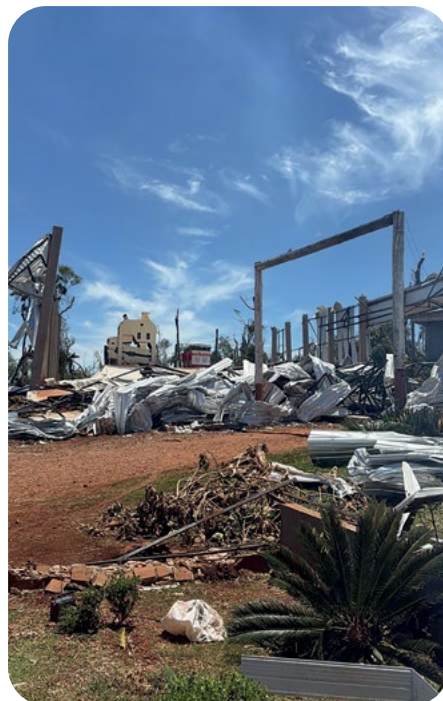
Em Rio Bonito do Iguaçu, o produtor Juliano Jurisch guarda os registros dos estragos e conta que a família ainda está traumatizada
